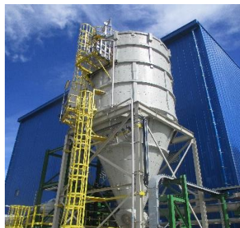
ภาพที่ 2-4 เครื่องดักฝุ่นแบบ Bag Filter
