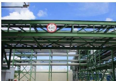
ภาพที่ 2-35 ป้ายบอกความสูงของ Pipe Bridge
