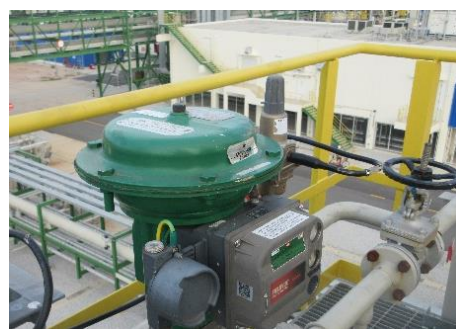
ภาพที่ 2-9 วาล์วระบายความดันที่ท่อเผา/วาล์วฉุกเฉิน
