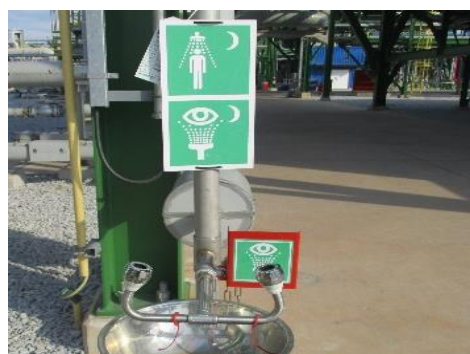
ภาพที่ 2-29 อ่างล้างตาและร่างกายฉุกเฉิน
