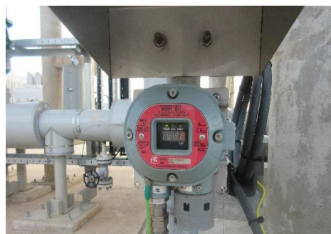
ภาพที่ 2-8 Gas Detector
