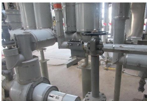
ภาพที่ 2-9 วาล์วระบายความดันที่ท่อเผา/วาล์วฉุกเฉิน
