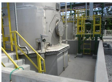
ภาพที่ 2-33 คั่นกันคอนกรีตล้อมรอบลานล้างเก็บกัก
