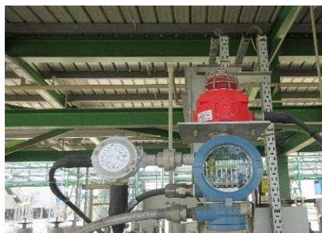
ภาพที่ 2-36 ติดตั้งบล็อกควาล์วที่ท่อ และเครื่องตรวจวัดอัตราการไหล
