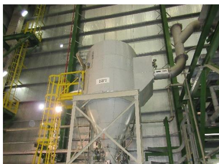
ภาพที่ 2-3 เครื่องดักฝุ่นแบบ Cyclone Separator
