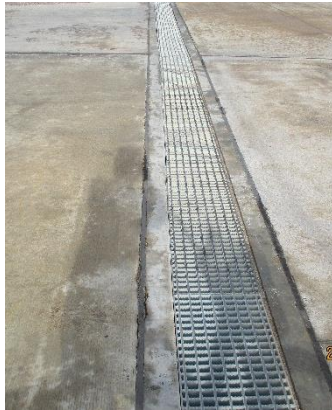
ภาพที่ 2-17 รางระบายน้ำในพื้นที่โครงการ
